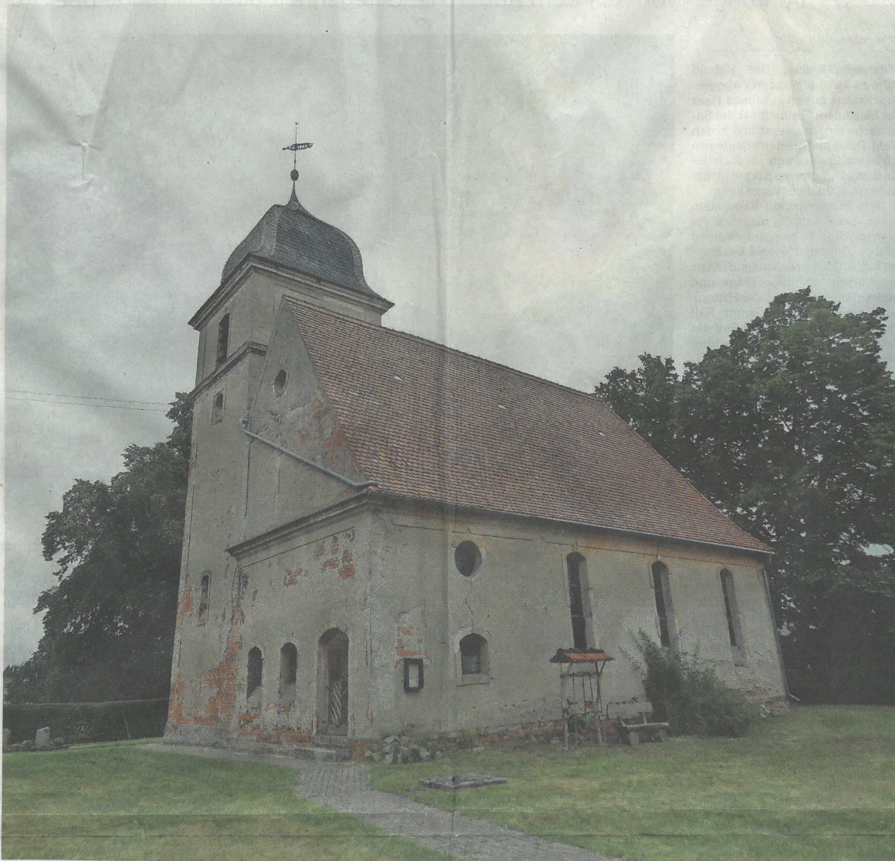
Die Einweihungsfeier für die Kirche in Niendorf erfolgte am 28. August 1909. Ihr Vorgänger, ein Fachwerkbau, wurde abgetragen.
